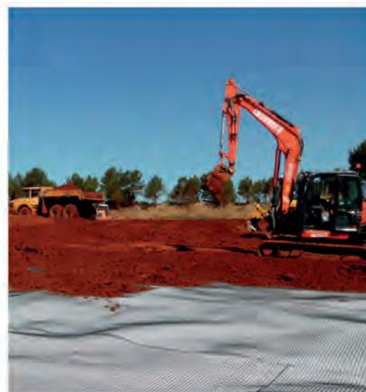
Le spécialiste des solutions destinées au génie civil et à la construction élargit sa gamme de géogrilles MacGrid extrudées, tissées ou collées, avec la MacGrid CE 40S. Ce nouveau géocomposite de traficabilité permet d'accéder et de réaliser des travaux sur des matériaux très peu porteurs, produits par les industries extractives comme les mines, les carrières ou l'industrie de transformation des minerais.
