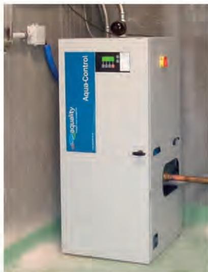
Aquality propose une gamme de solutions pour la valorisation d'eau de pluie et le recyclage des eaux grises. Dans son offre, elle dispose du système Aqua-Control, une unité compacte intégrant un surpresseur, une interface de contrôle et un système d'appoint en eau potable.
